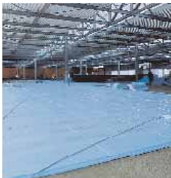
il. 17 » Płyty termoizolacyjne FLOORMATE układane luzem, krawędzie na styk
