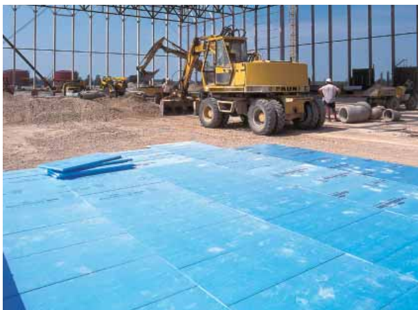
il. 13 » Lotnisko w Monachium – izolacja posadzki hangaru
