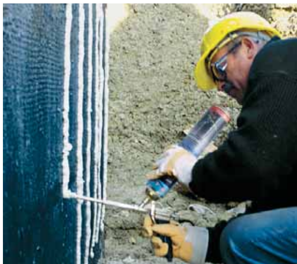
il. 10 » Nakładanie kleju INSTA-STIK™ PM bezpośrednio na ścianę fundamentu.
