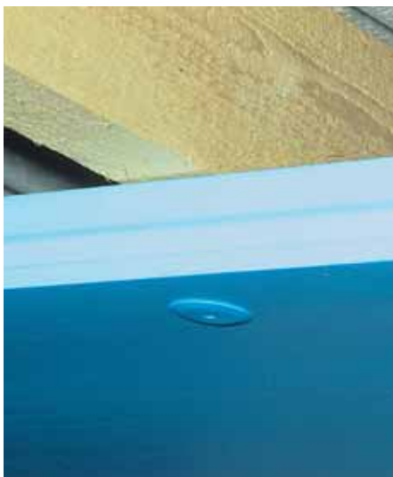
il. 11, 12 » Mocowanie widoczne za pomocą kołków
